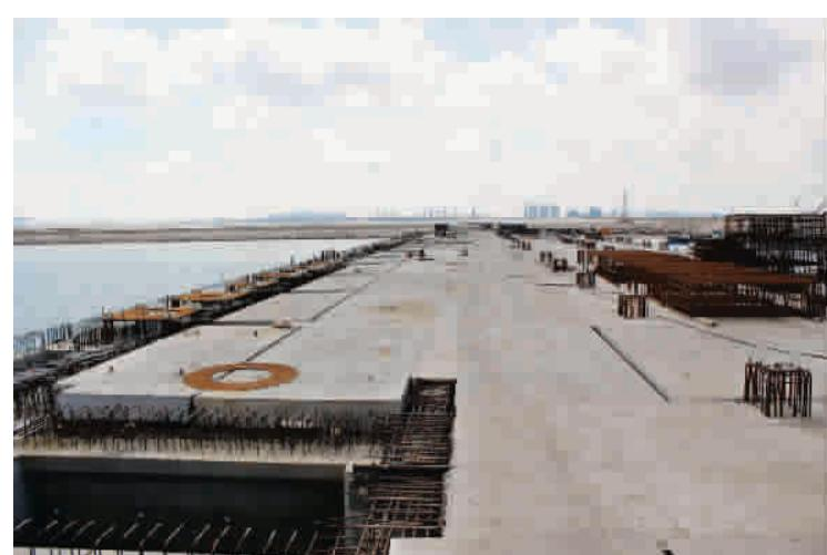
打桩19”轰隆锤击声的停止,位于承台第五结构段桩号B42预制桩完美落入相应位置,至此黄骅港综合港区泰地液体化工码头部分预制桩沉桩已经完成过半,累计完成了270根。为码头的建设,打下了坚实的基础。
