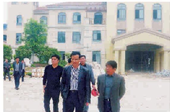
房产集团总裁张朱奔(右一)在周口公司总经理杜润根(前右二)的陪同下,视察现代城施工现场。
