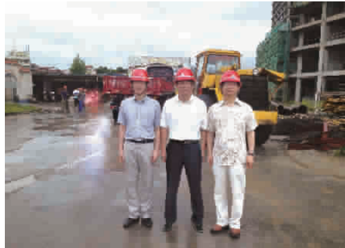
图为李浩然(右一)陪同张跃总裁(中者)在施工现场视察
