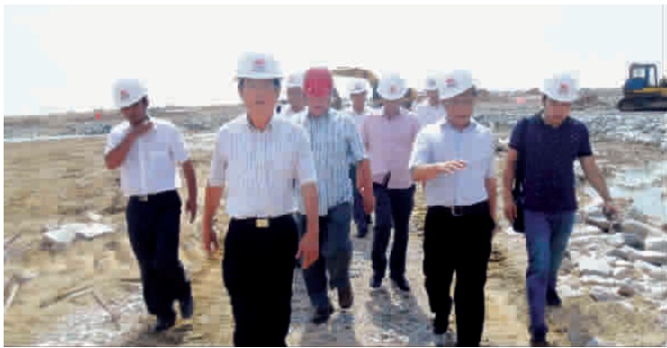
张跃总裁(左二)视察连云港新世纪项目陆域罐区施工现场
