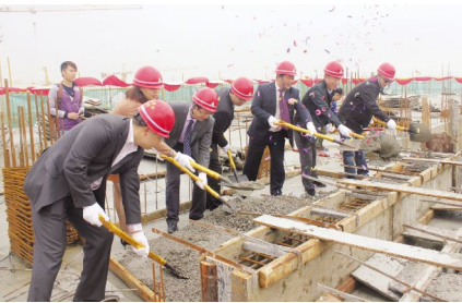
各位领导为封顶浇筑混凝土
